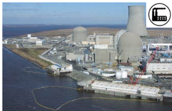
▲ Figura 6: central eléctrica con una toma de agua en primer plano. Se despliegan varias barreras de desviación para evitar la entrada de hidrocarburos.
