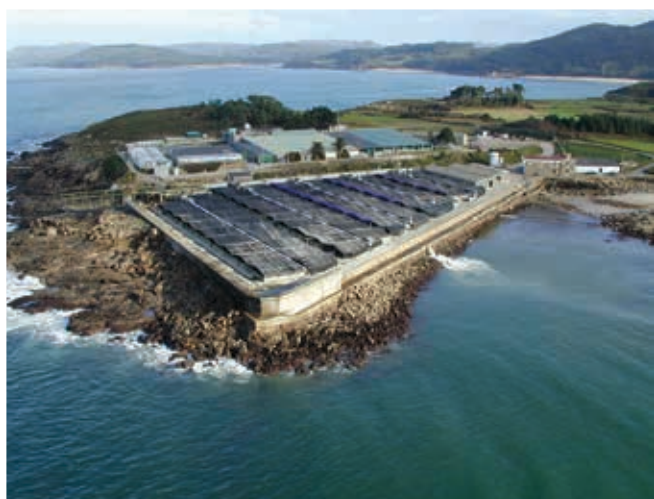
▲ Figura 7: los criaderos de pescado en tierra requieren grandes volúmenes de agua de mar limpia. Las tomas de agua suelen encontrarse por debajo de la superficie y podrían verse afectadas por hidrocarburos dispersos.
