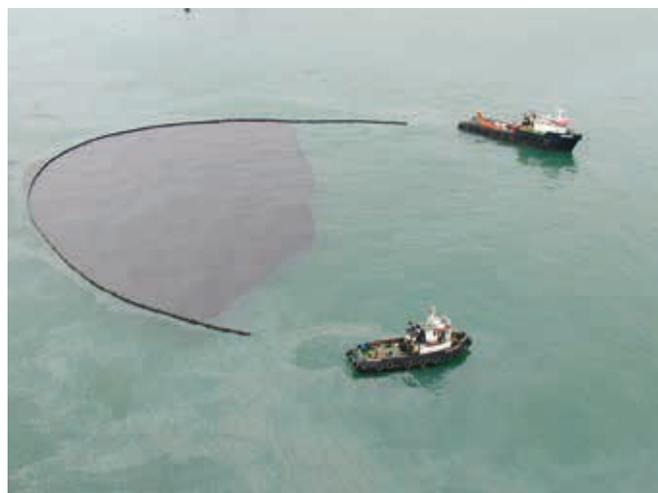
▲ *Figura 5: aunque los hidrocarburos se hayan contenido satisfactoriamente, puede que estos esfuerzos resulten vanos si no se cuenta con medios de recolección de la superficie del agua y de almacenamiento temporal de los hidrocarburos.*
